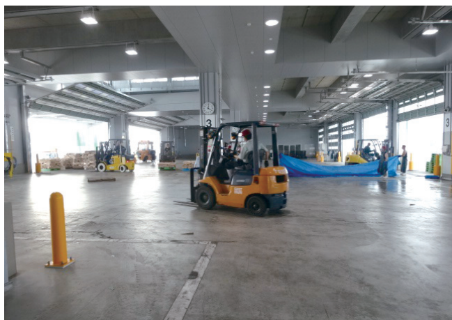
塩竈市魚市場 荷捌き施設内
