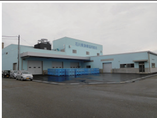
石川県漁業協同組合 新冷蔵庫
