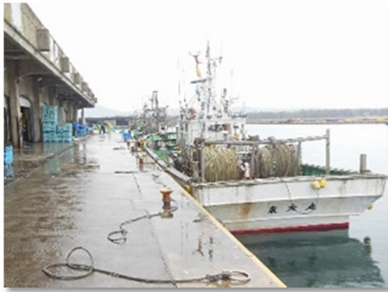
陸揚げ岸壁と荷捌き施設
