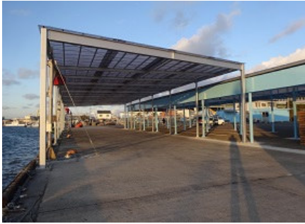
陸揚げ岸壁庇と荷捌き施設
