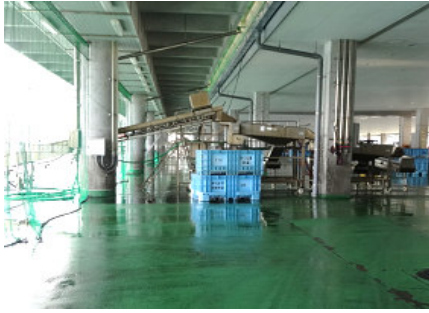
すくも湾漁業協同組合本所 荷捌き施設
