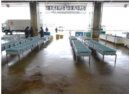
久慈市漁業協同組合 荷捌き施設
