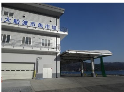
大船渡市魚市場岸壁と荷捌き施設
