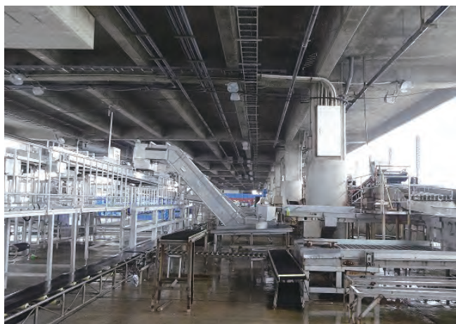
松浦魚市場 荷捌き施設内選別機
