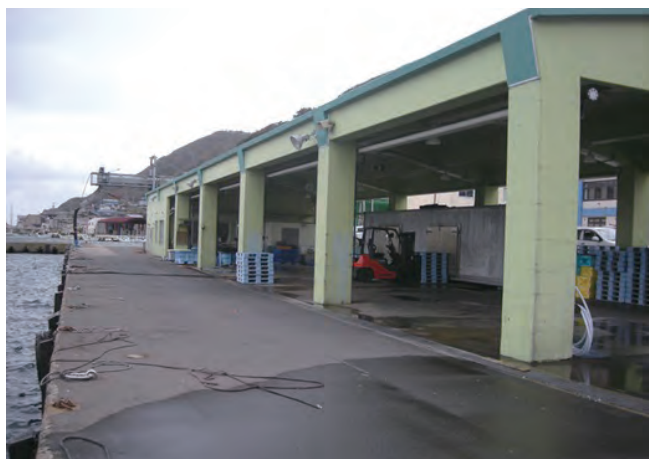
下前漁業協同組合 荷捌き施設外観
