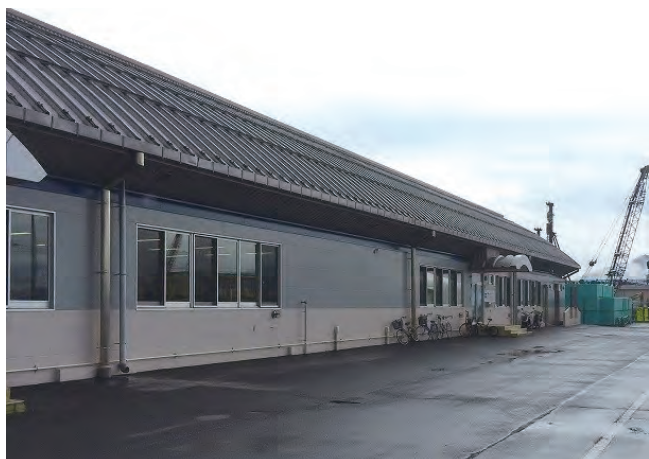
宮古漁業協同組合 荷捌き施設
