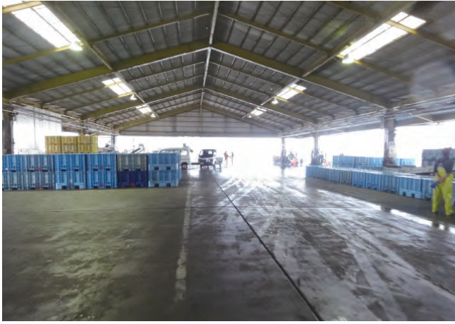
長島港産地卸売市場 荷捌き施設内
