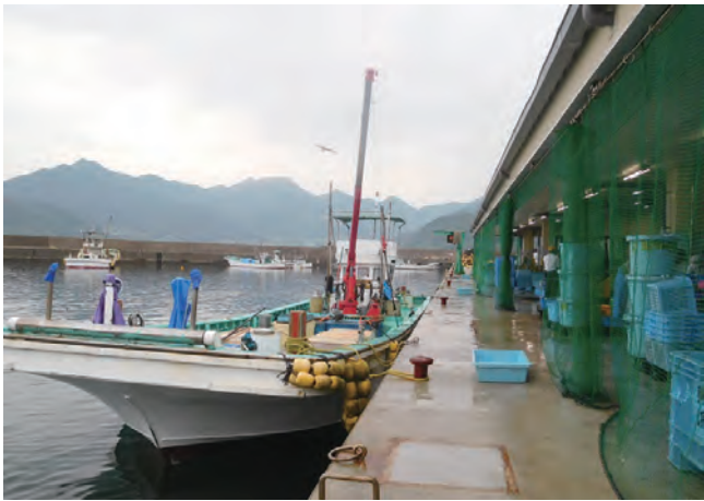
熊野漁業協同組合遊木浦地方卸売市場
